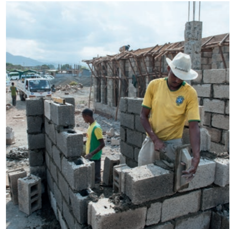
Überall in der Stadt baut Menschen für Menschen Schweiz Sanitäranlagen. Am viel frequentierten Busbahnhof entsteht ein WASH-Café.
