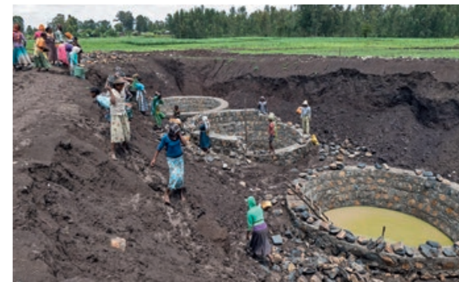
Nur zwei Monate lang gibt es ausreichend Regen. Deshalb unterstützt Menschen für Menschen Schweiz die Stadtbewohner mit dem Bau von Zisternen.
