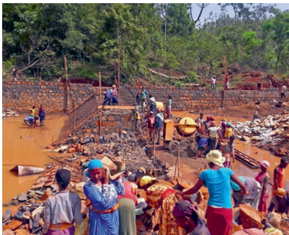
Am Bau des Stauwehrs in Seka wird die lokale Bevölkerung beteiligt
