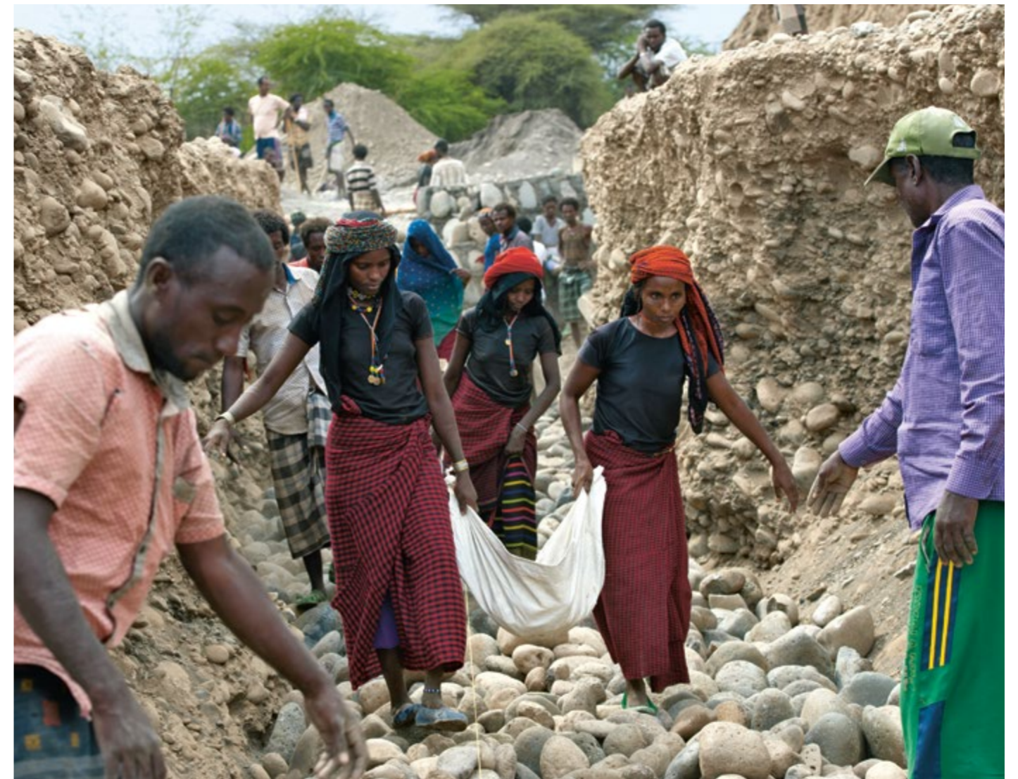
Afar-Nomaden helfen beim Bau eines Bewässerungskanal in der Savanne von Subuli.
