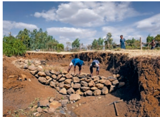
In Fogera gibt es viele «Gullys». Das sind Gräben, die sich bei Wolkenbrüchen vertiefen und Boden mitreissen. Durch den Bau von Quermauern und dem Pflanzen von Bäumen können die Bauern die Erosion stoppen.
